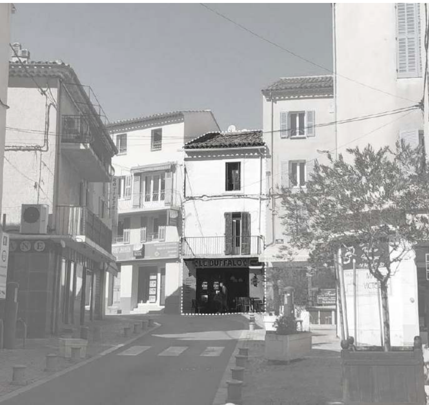
La maison avant travaux depuis la rue
